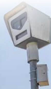
Şekil 2: ASELSAN Trafik Radarı saha uygulaması
