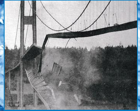
Şekil 5: Tacoma Köprüsü ve doğal frekans
